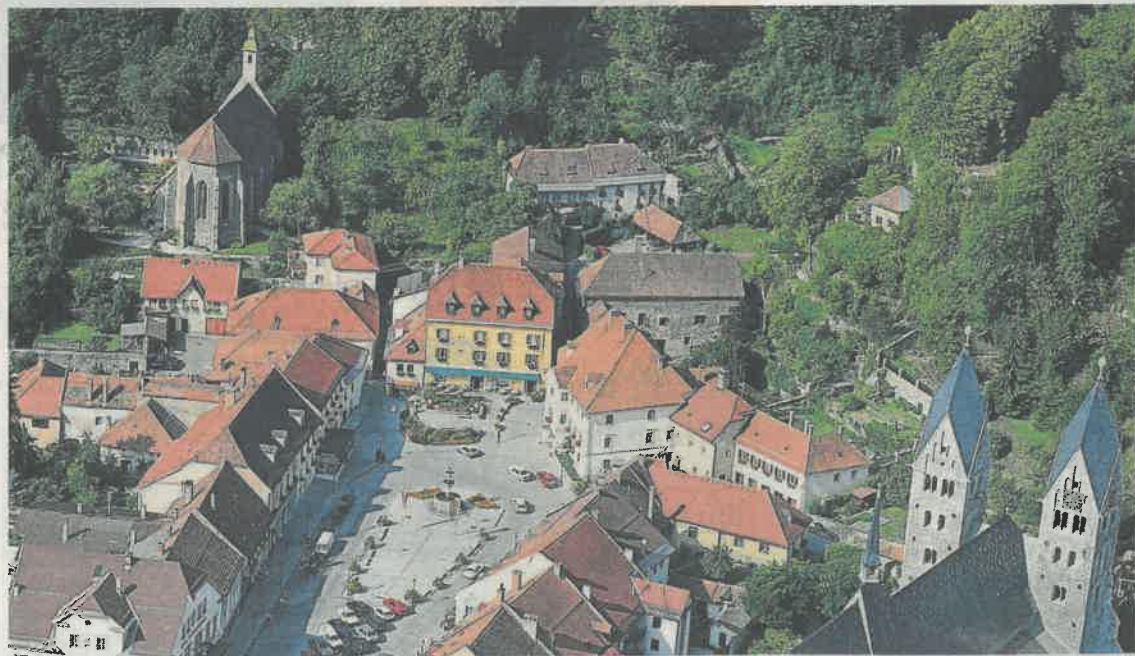
Die historische Altstadt Friesachs soll durch das Runse-Projekt oberhalb der Stadt geschützt werden. Bauarbeiten beginnen erst nächstes Jahr
